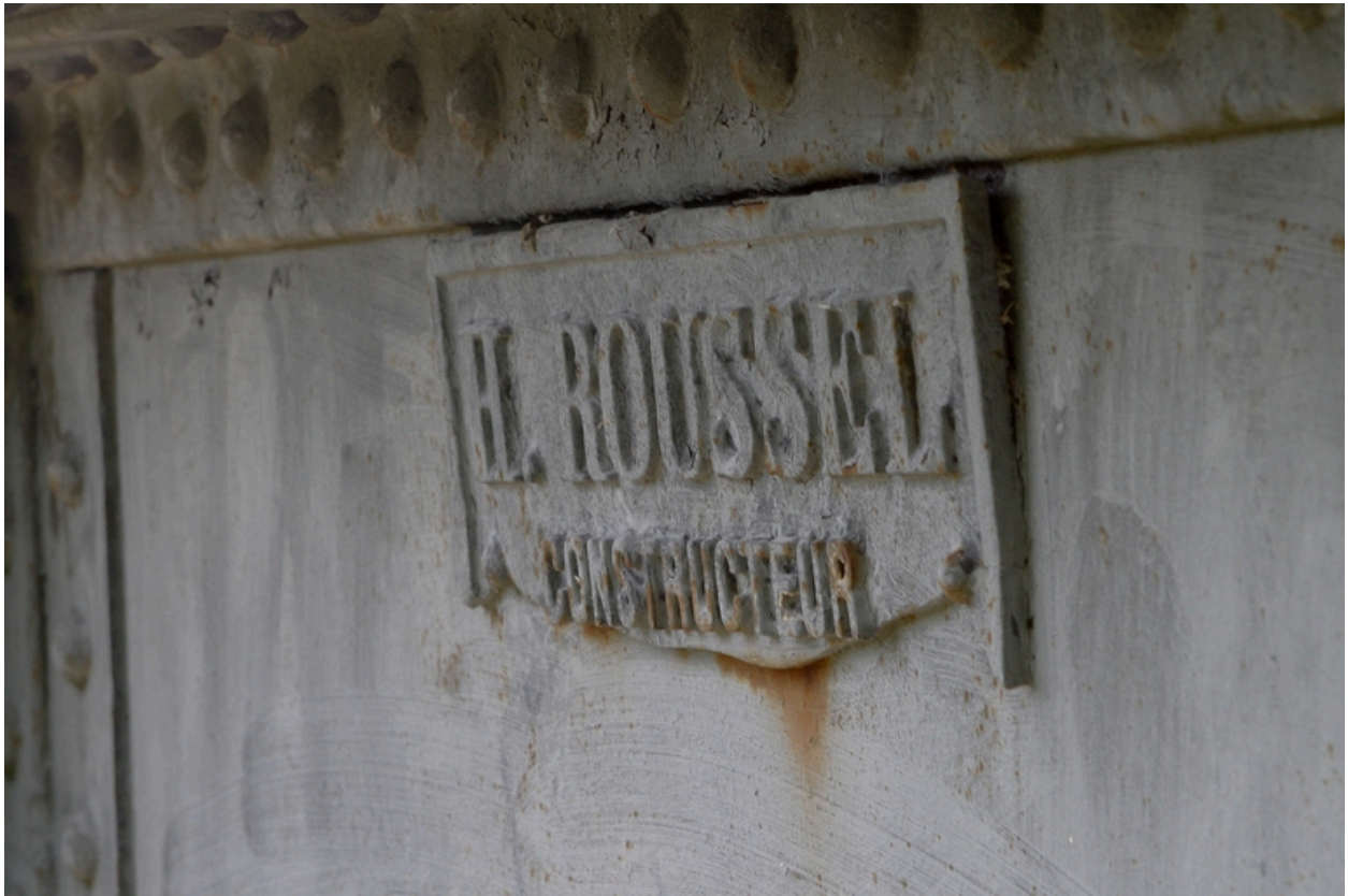
Plaque du constructeur du pont.
