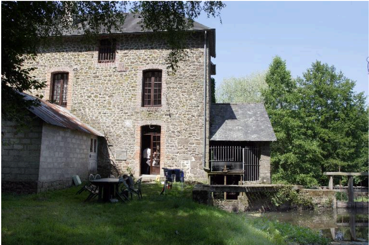
Le moulin vu depuis l'amont à l'est.
