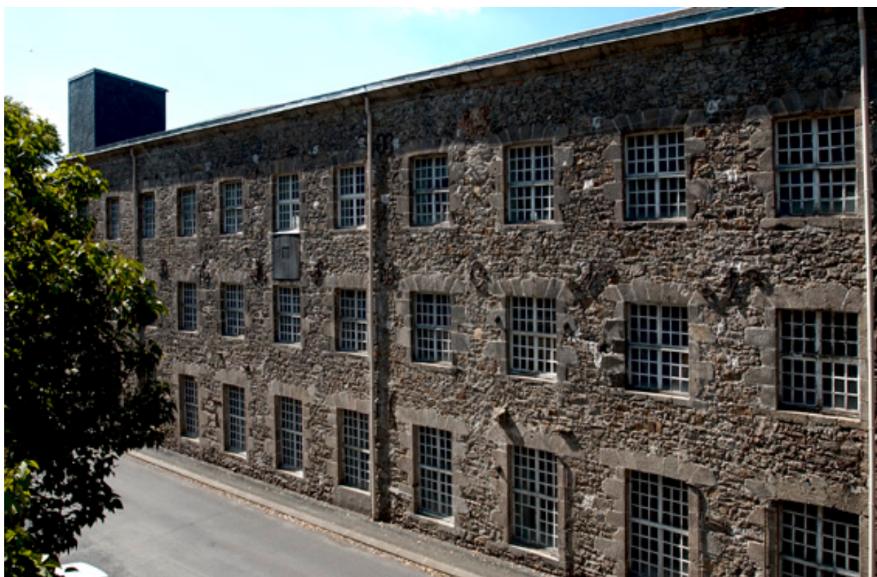
Elévation nord de la filature : détail des travées et de l'inscription Bonnet& Fils. Vue d'ouest en est.
