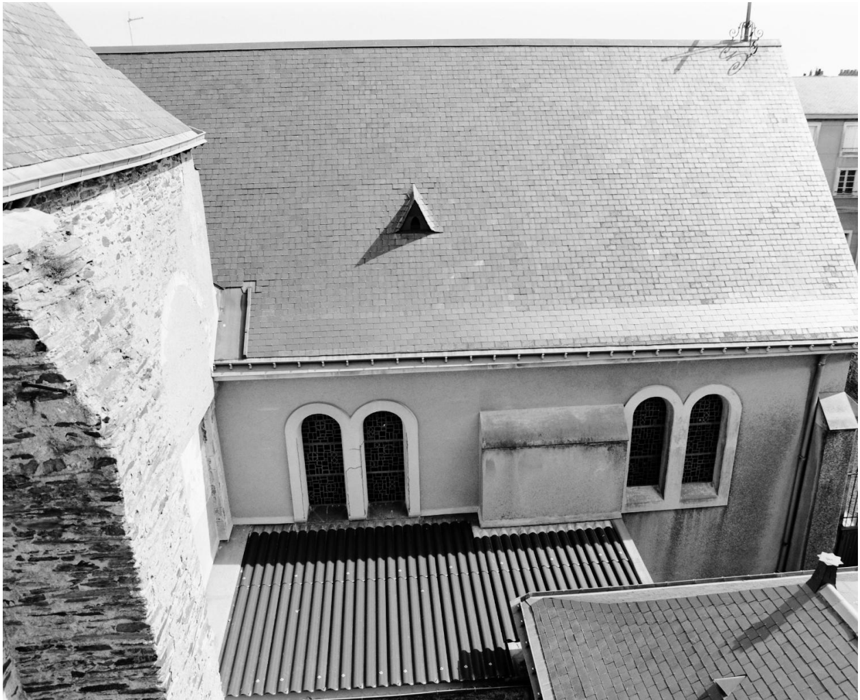
Eglise Sainte-Thérèse actuelle : façade latérale gauche (ouest).
