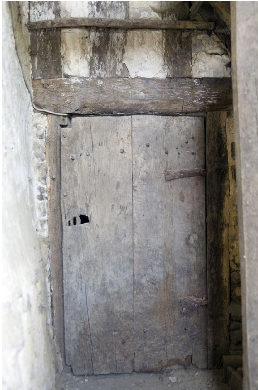
Tour d'escalier : porte vers la cave.
