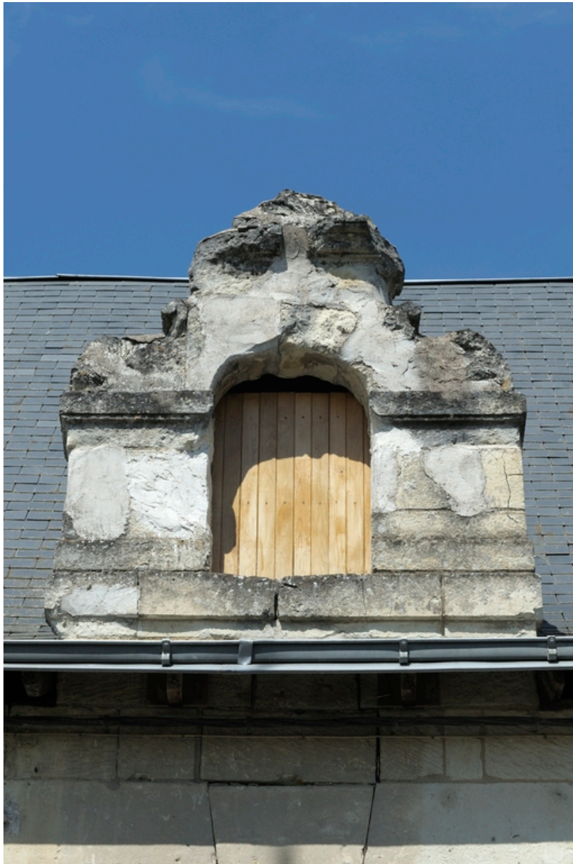
Lucarne latérale (ouest), à baie en plein-cintre et amortissement à volutes.
