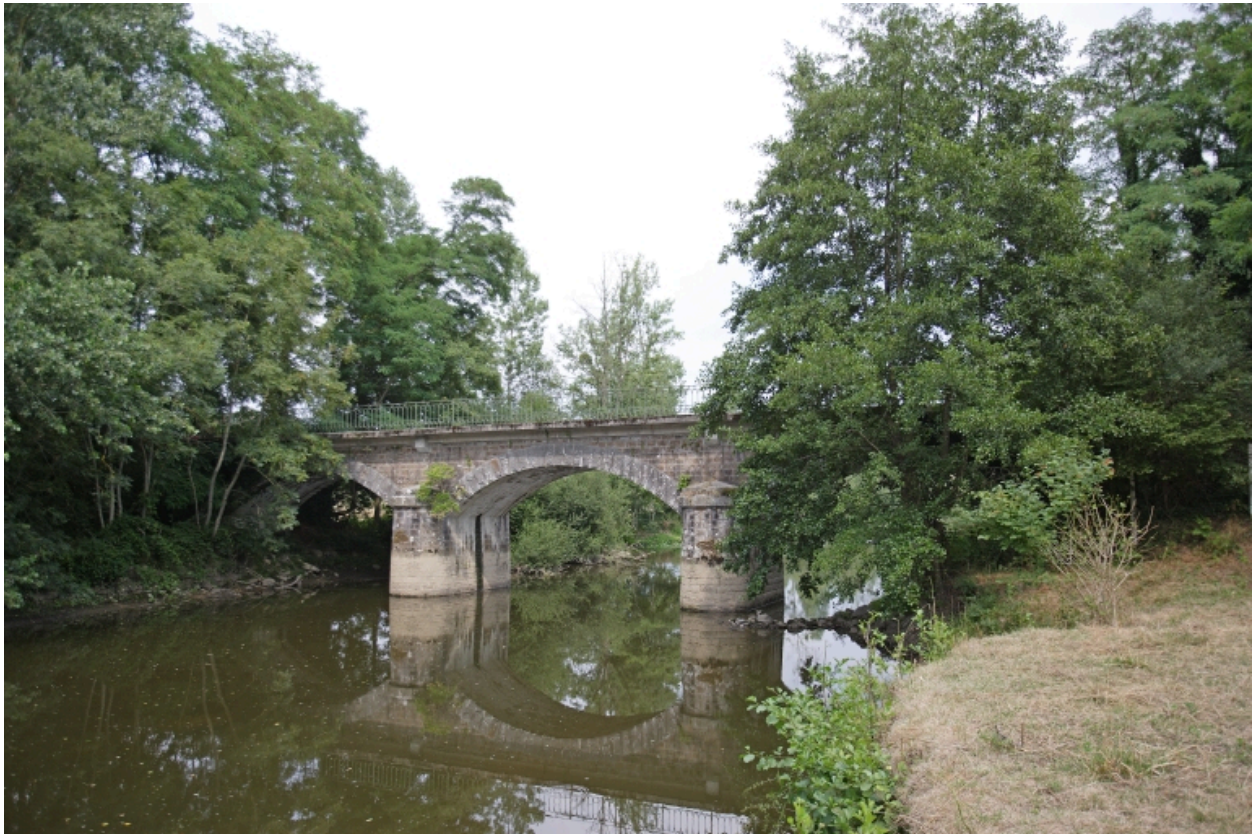
Vue d'ensemble depuis la rive gauche, en aval.
