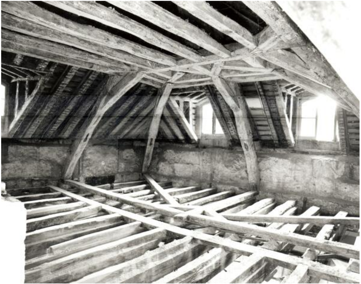
Corps principal, étage de comble, charpente, vers l'angle antérieur gauche (nord-est), durant les travaux de restauration 1997-1998.
