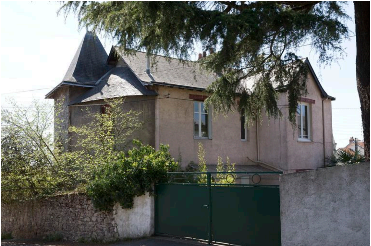
Arrière de la maison située au n° 40 rue de l'Abbaye.
