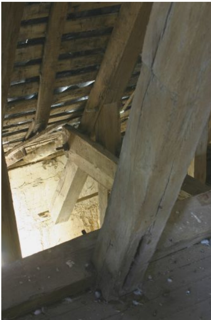
Le chemin de ronde de la face sud du logis.
