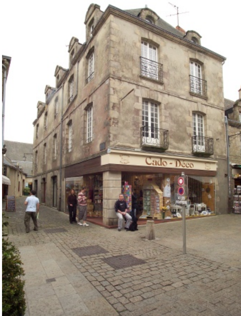
Vue générale vers le Sud-Ouest.
