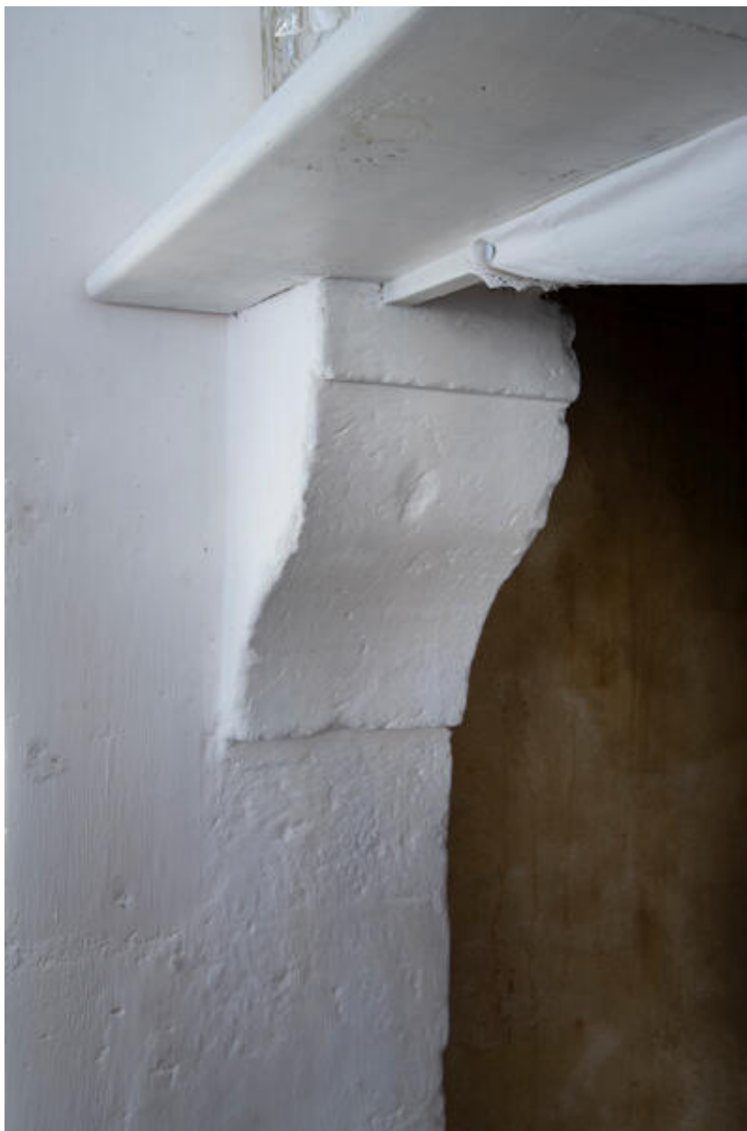
Ferme 1 : console de la cheminée de la pièce principale.
