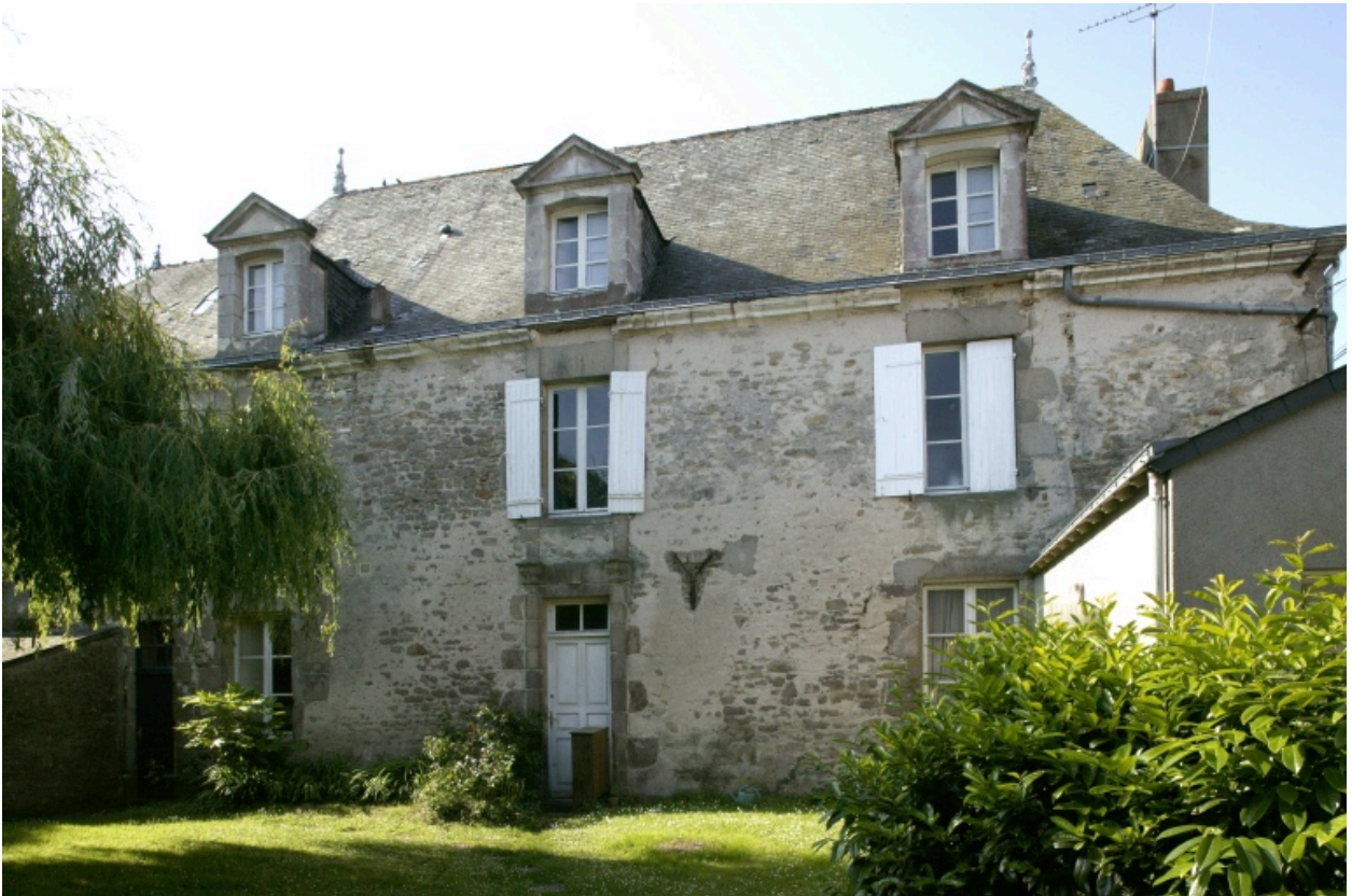
Façade nord de l'hôtel de Kerhué.
