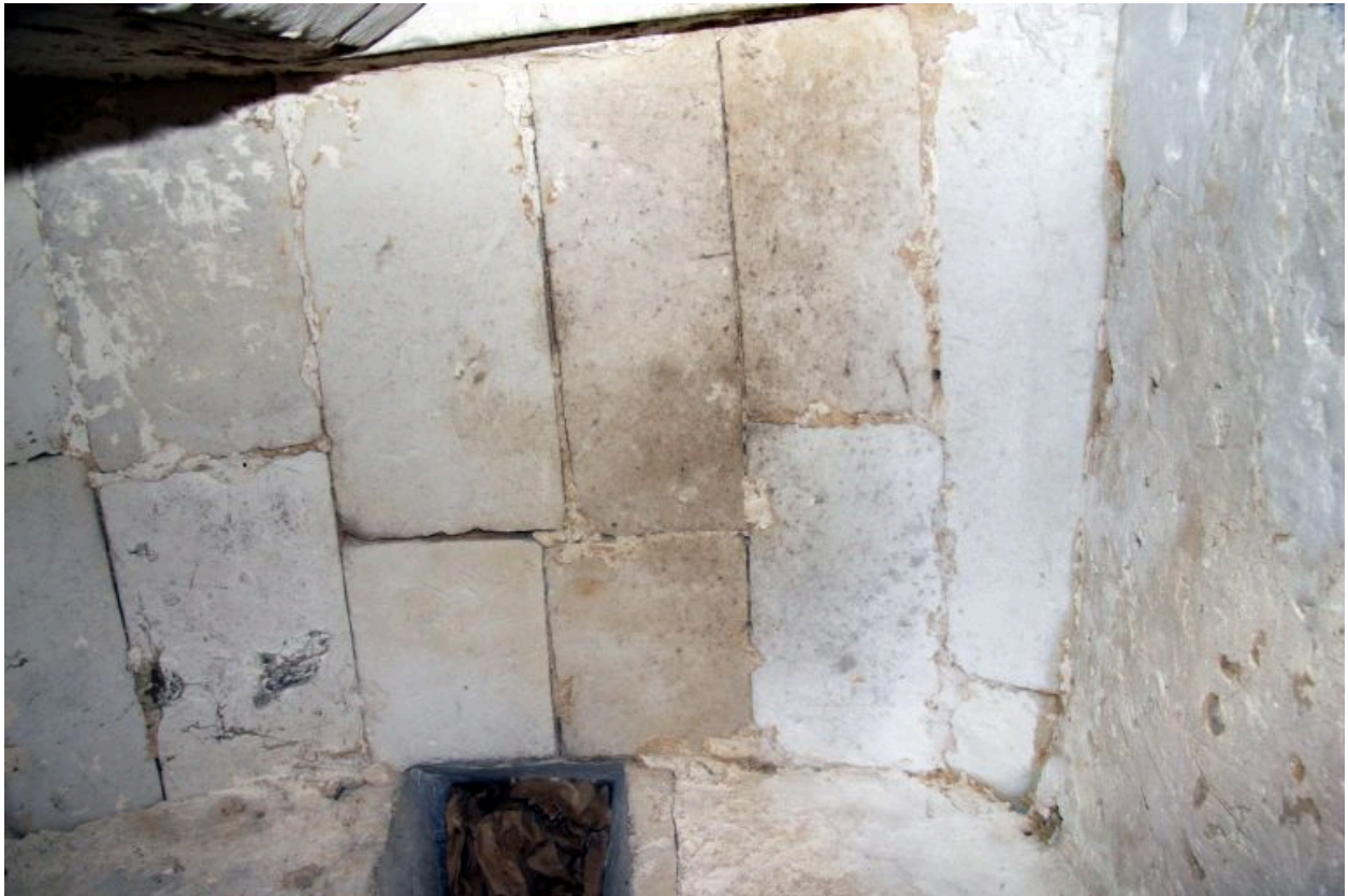
Tourelle, rez-de-chaussée, cabinet : voûte.
