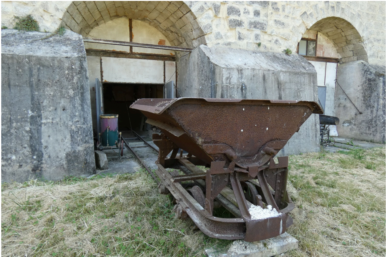
Wagonnet à l'entrée de la trappe de défournement d'un des fours.
