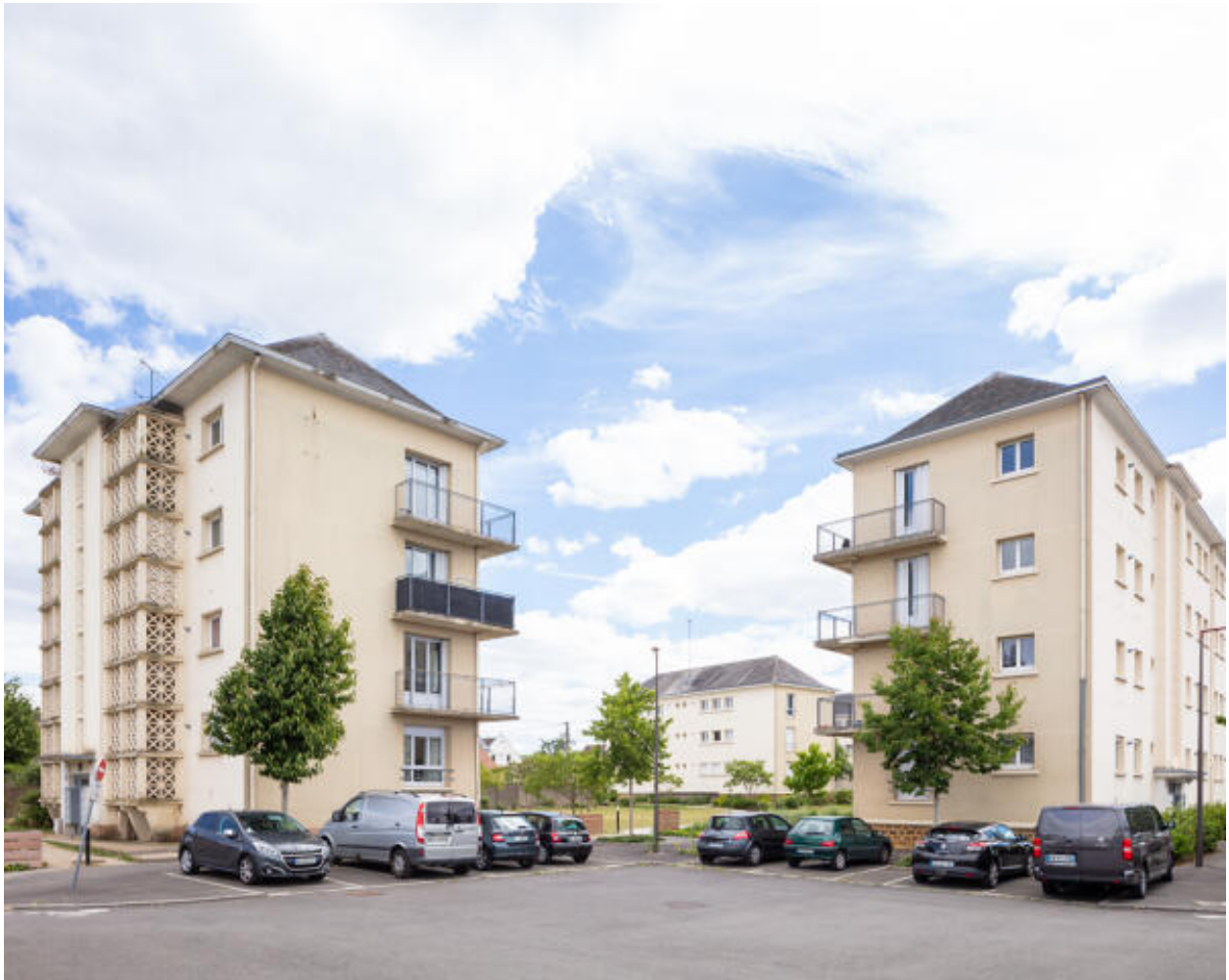
Vue de la cité depuis le nord-est.
