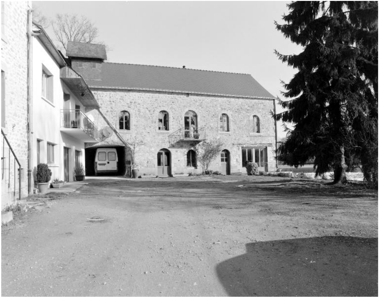
La façade sud (aval) du moulin.
