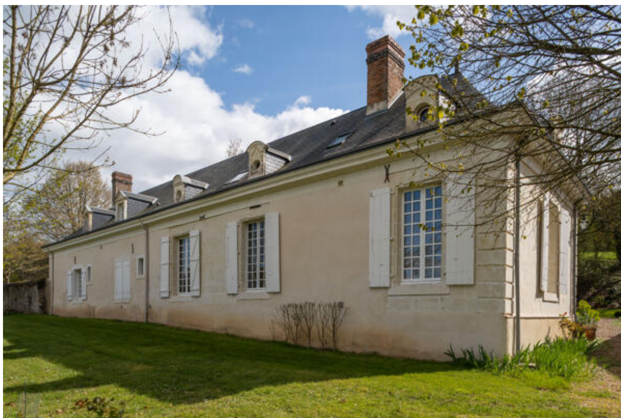
Le logis : façade nord.
