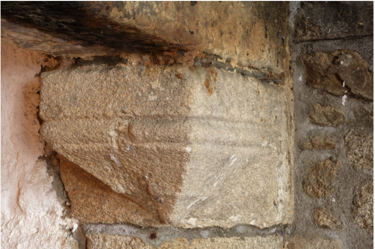
Détail d'une console de la cheminée (6 rue de l'Aha).
