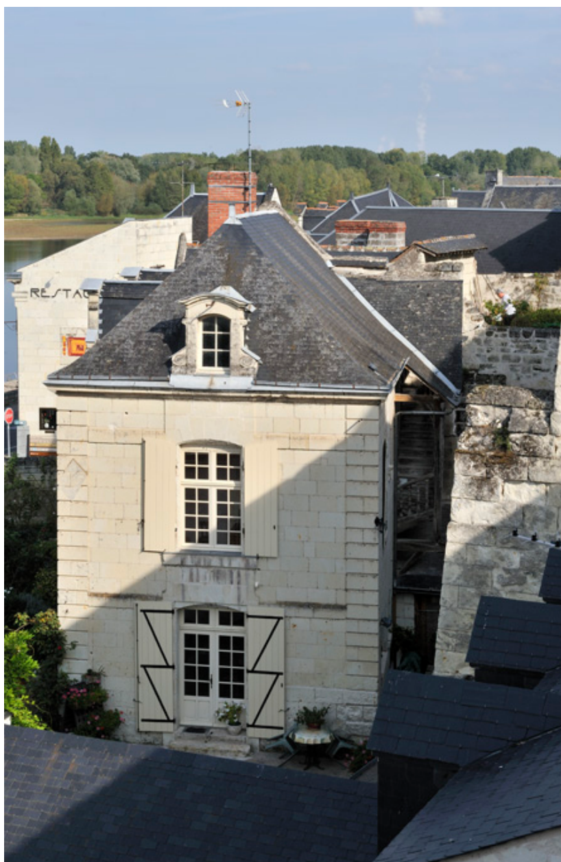
Vue d'ensemble sur le bâtiment principal, avec l'escalier extérieur côté sud.
