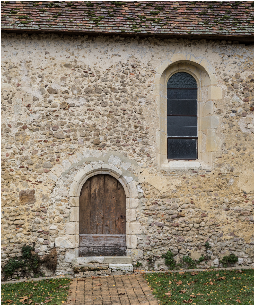
La porte et la fenêtre du mur sud de la nef.
