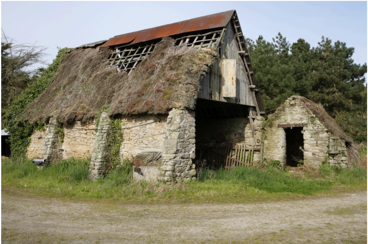
Vue de la remise.
