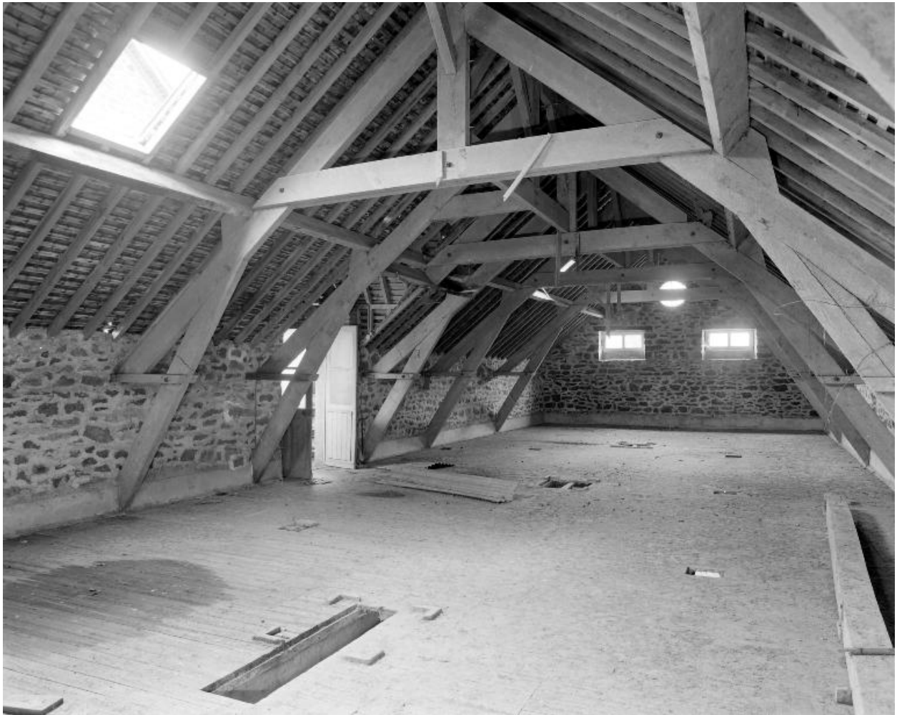
Le comble du bâtiment de stockage. A gauche, la porte d'accès à la passerelle.
