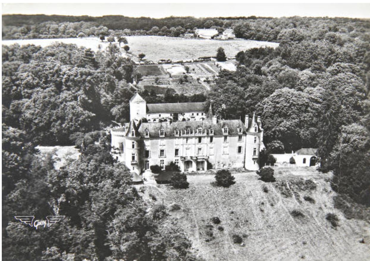
Vue aérienne depuis le sud, probabl. décennie 1950-60.
