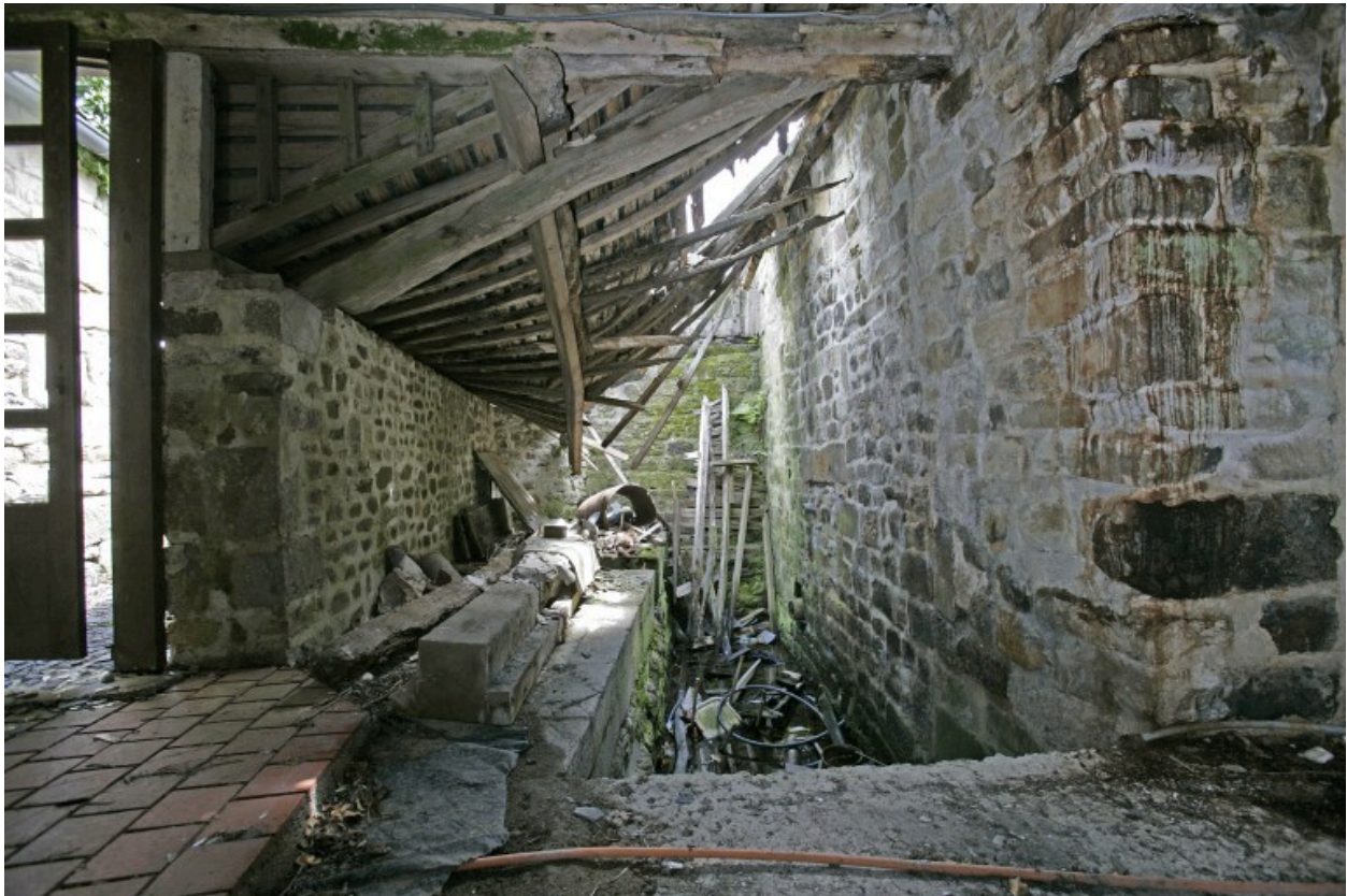
Vue intérieure du moulin depuis l'ouest : l'emplacement des roues.
