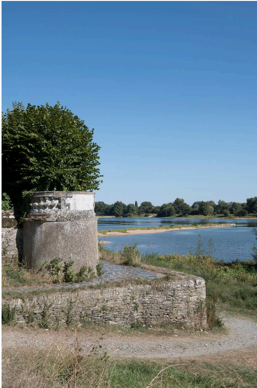
Vue de la tourelle d'angle sud depuis le chemin de halage.
