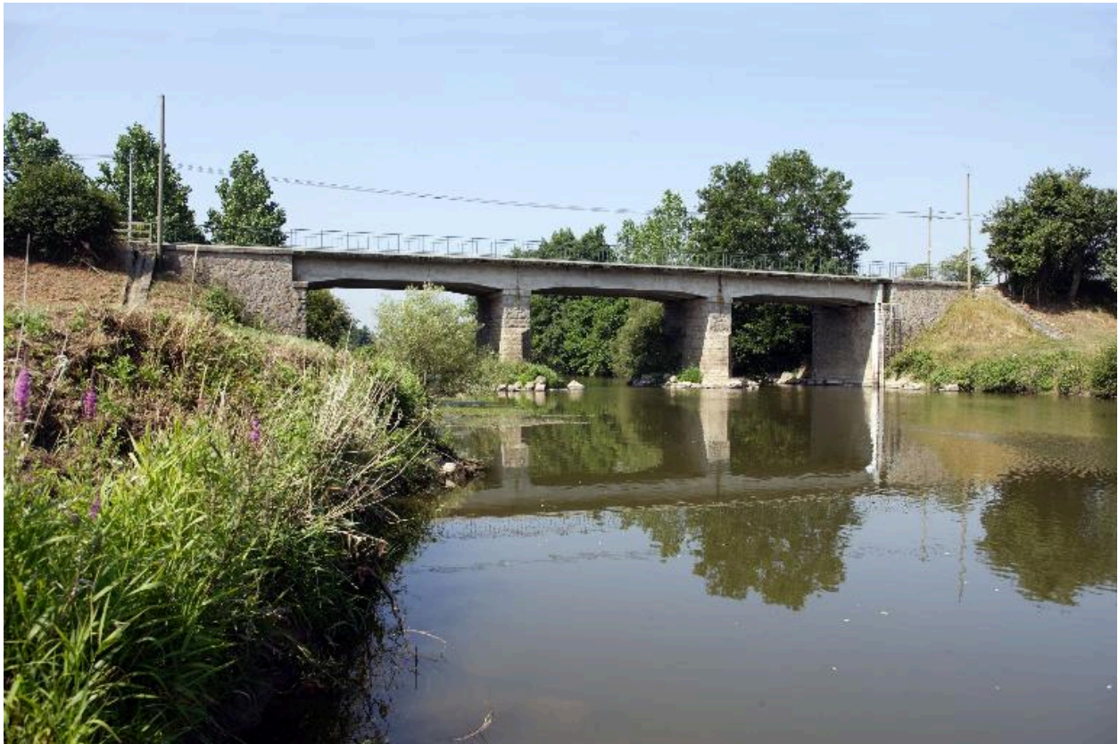
Vue depuis l'aval.
