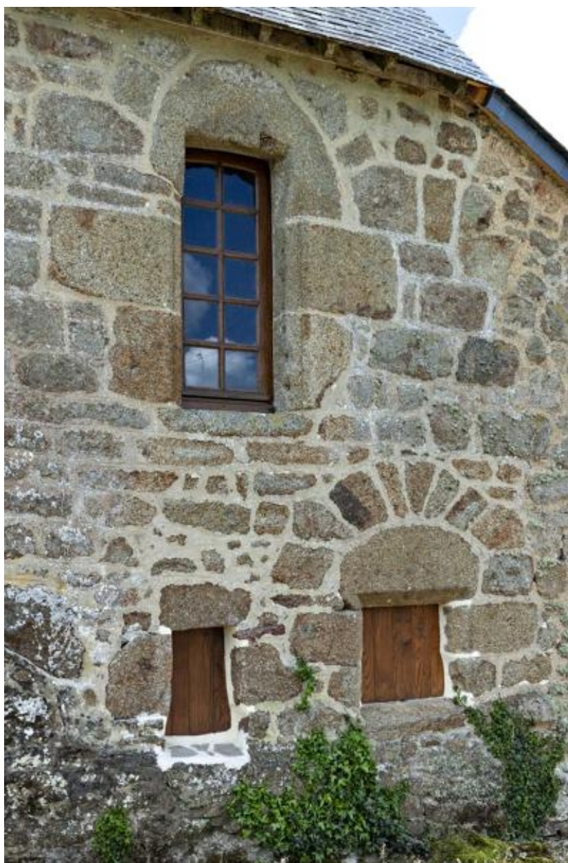
Baies de la façade nord.
