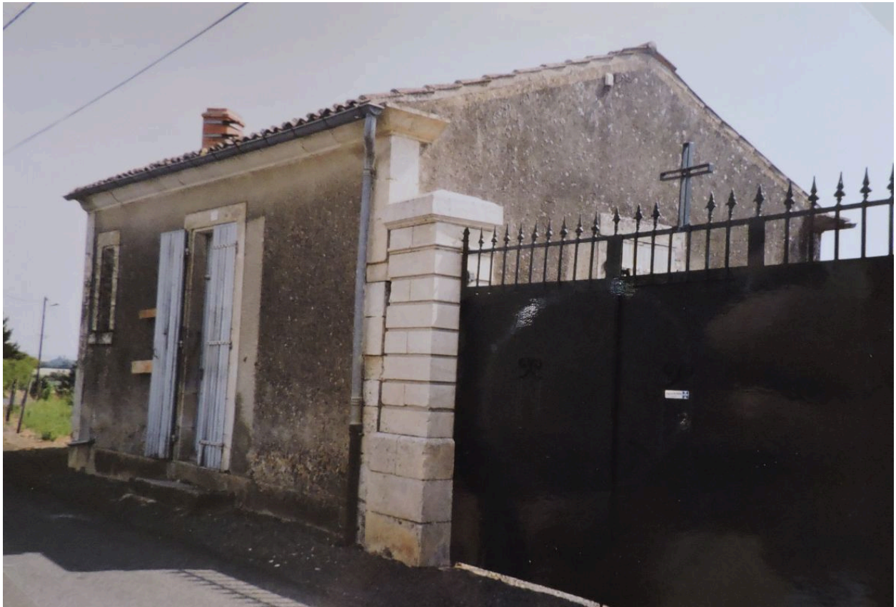
L'ancien logement de gardien vu depuis le sud-ouest vers 1998.
