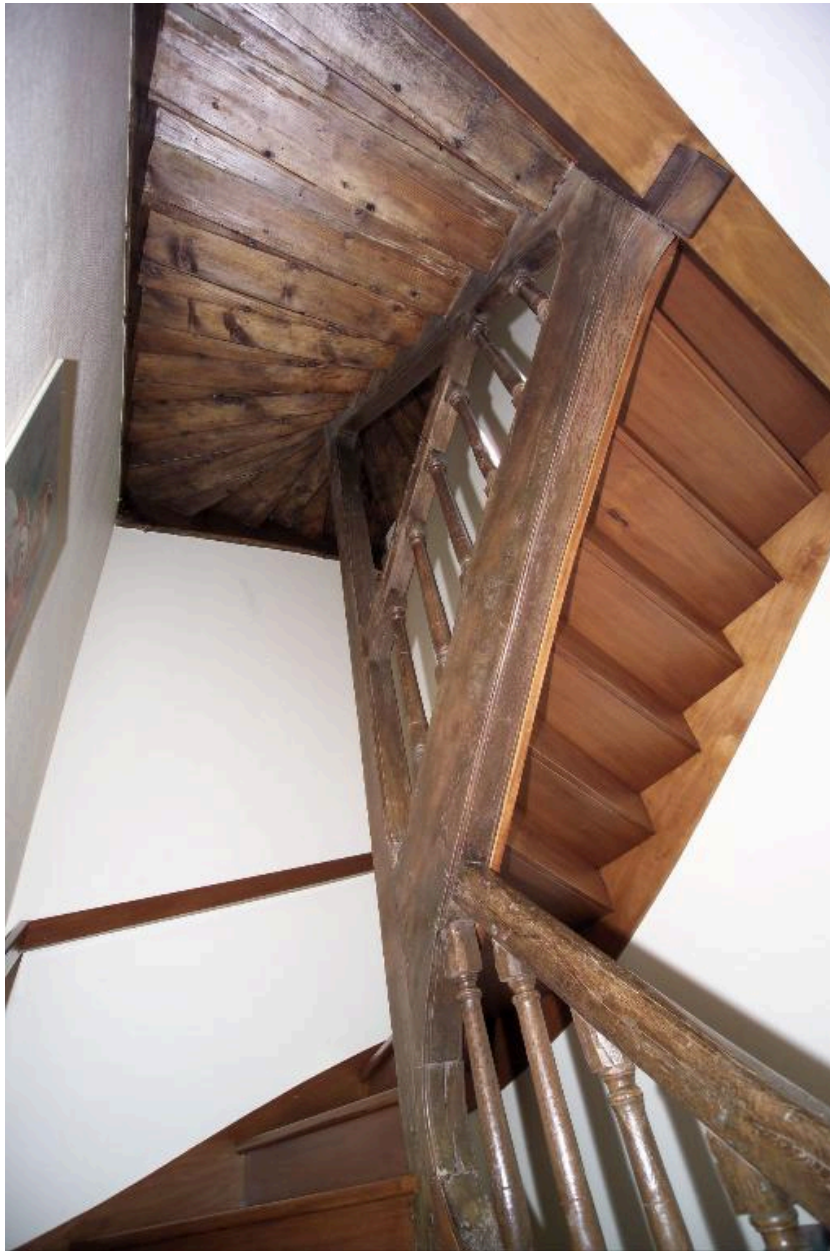
L'escalier articulant les deux corps de bâtiment, vue prise du premier vers le second étage.
