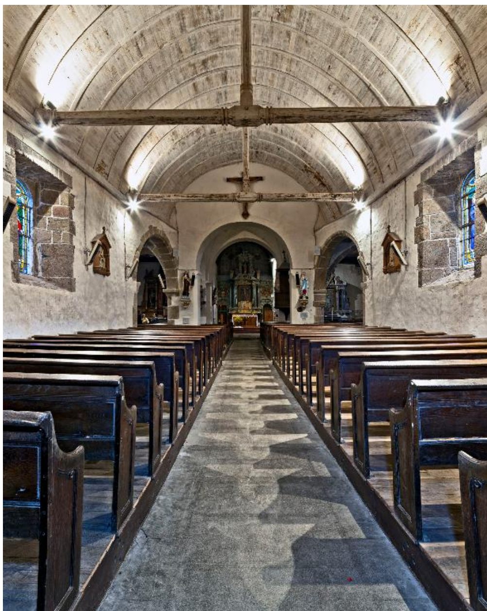
Vue intérieure d'ensemble depuis le bas de la nef.
