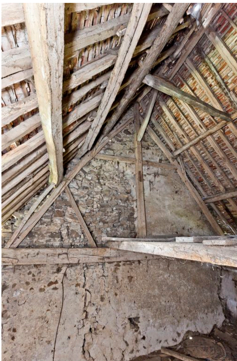
Face interne du pignon gauche du corps principal du logis.
