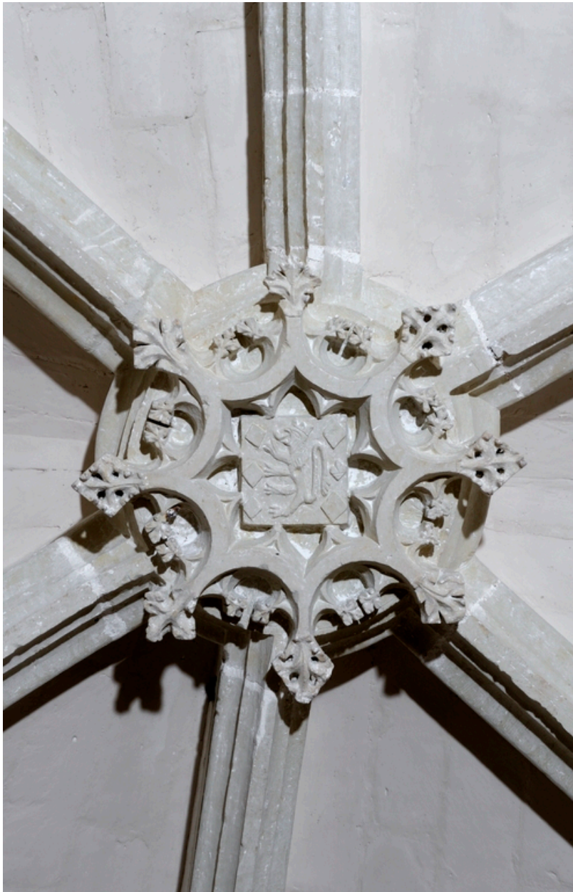
Ancienne chapelle nord (fin XVe siècle), étage. Voûte : clef aux armes des Chambes (après restaurations 2013).
