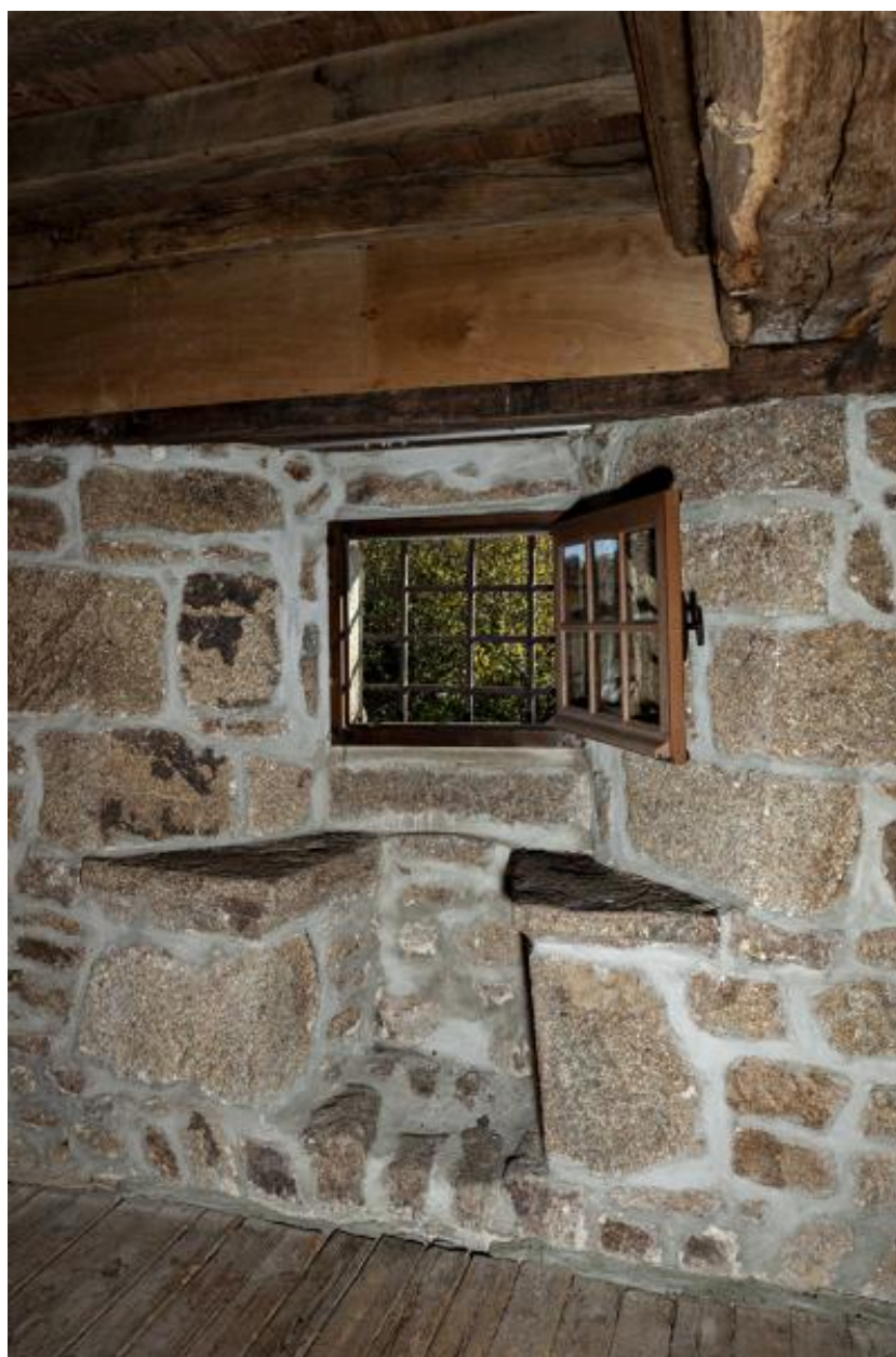
Logis sud, coussièges, fenêtre du comble.
