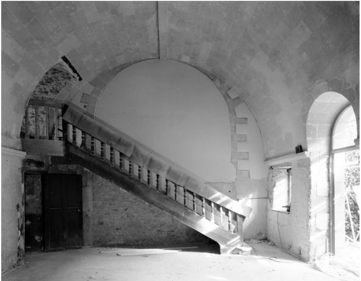
Choeur : vue d'ensemble, vers est. Au fond, arc ouvrant sur l'abside (disparue).
