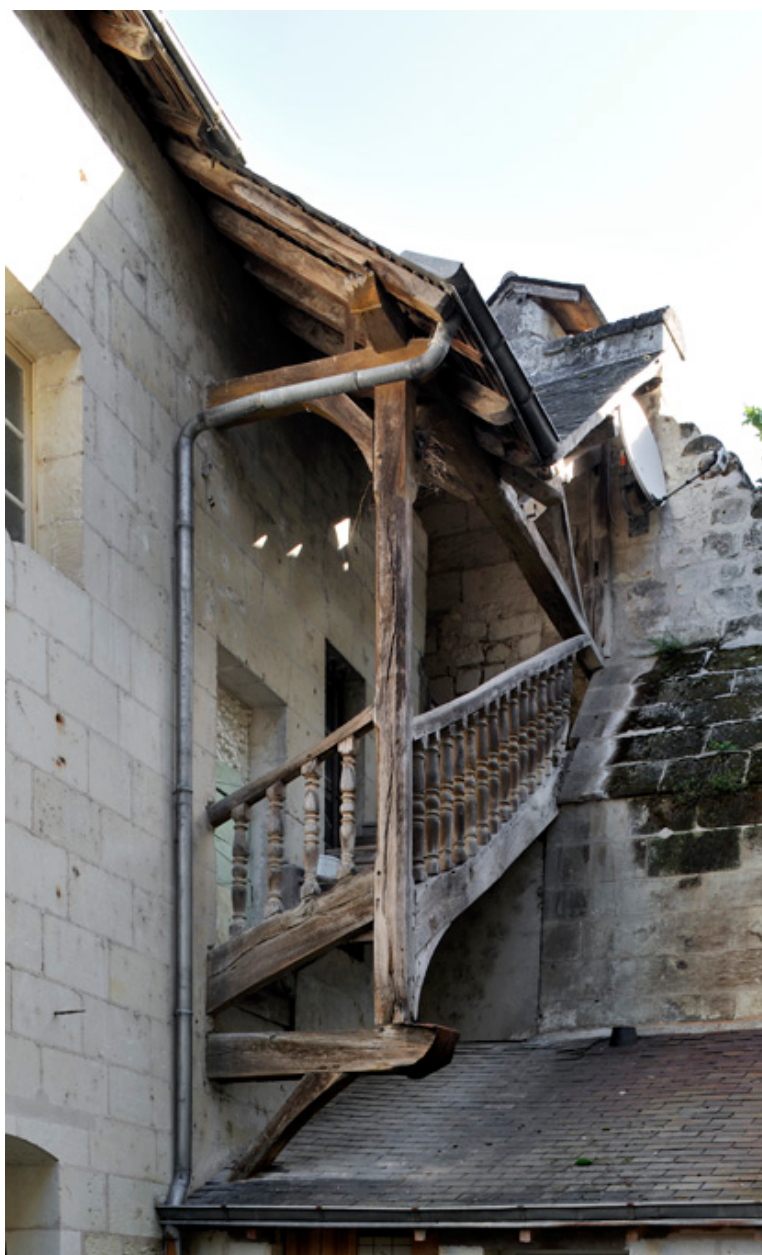
Escalier extérieur (ISMH) en façade postérieure de la maison principale
