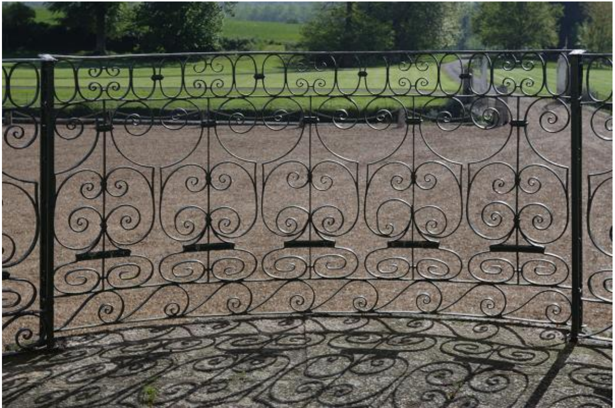
Le garde-corps du palier du perron du logis.
