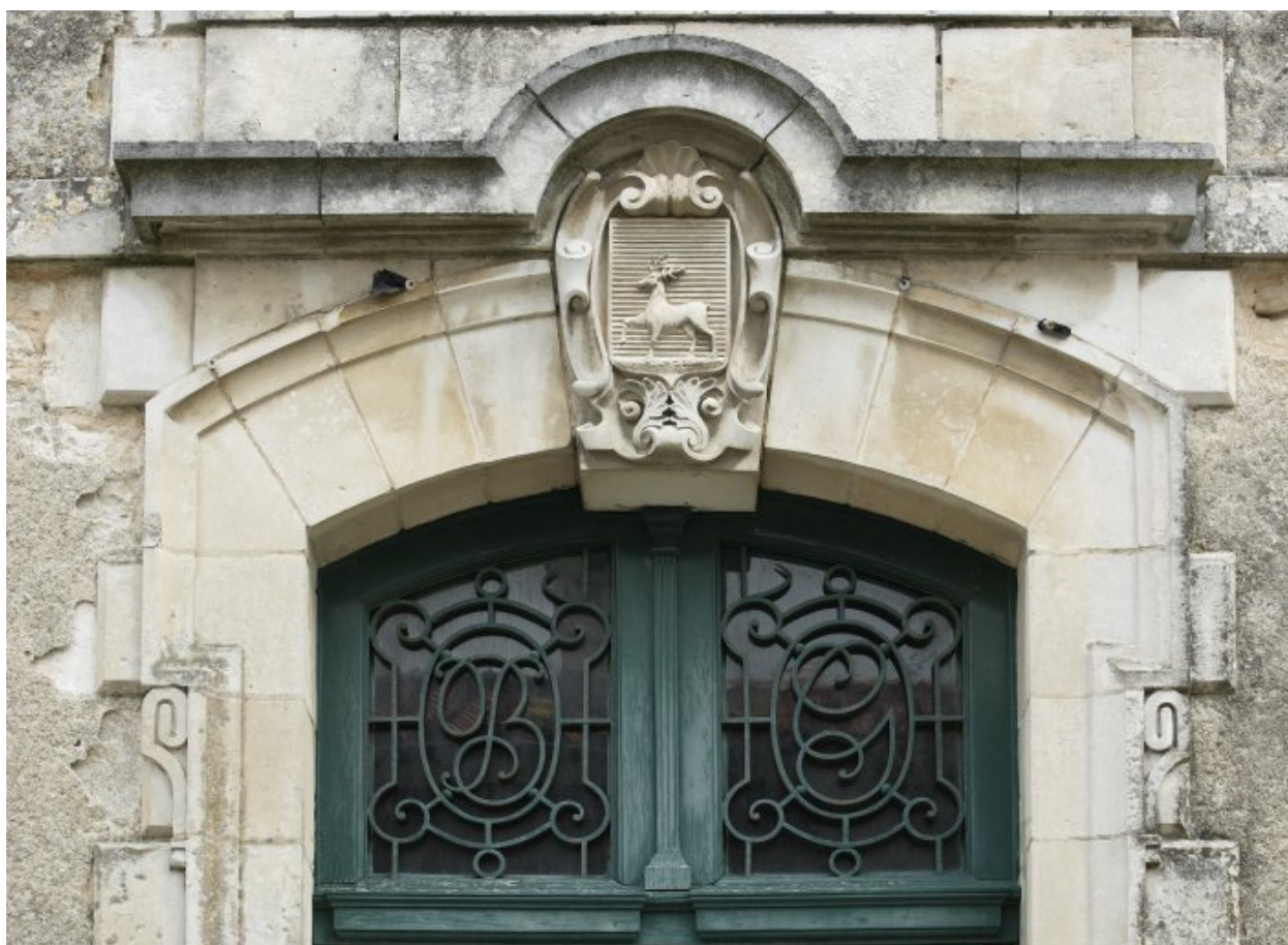
Façade rue Alexis-Vinçonneau : armes de la famille de la Boucherie, au-dessus de la porte d'entrée et monogrammes LB et G (La Boucherie du Guy).
