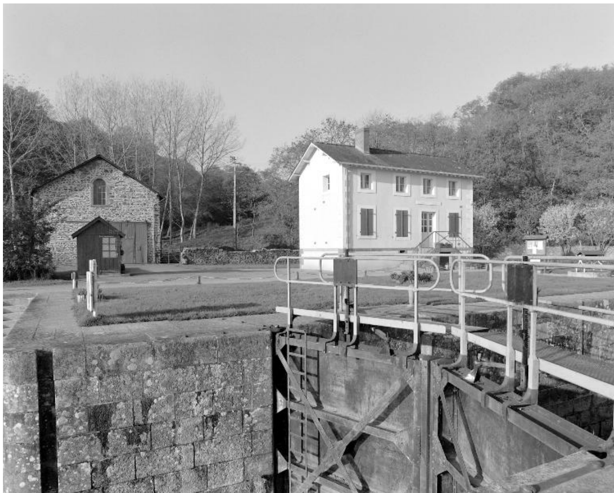
La centrale hydroélectrique, la maison éclusière et les portes aval de l'écluse, vus de l'est.
