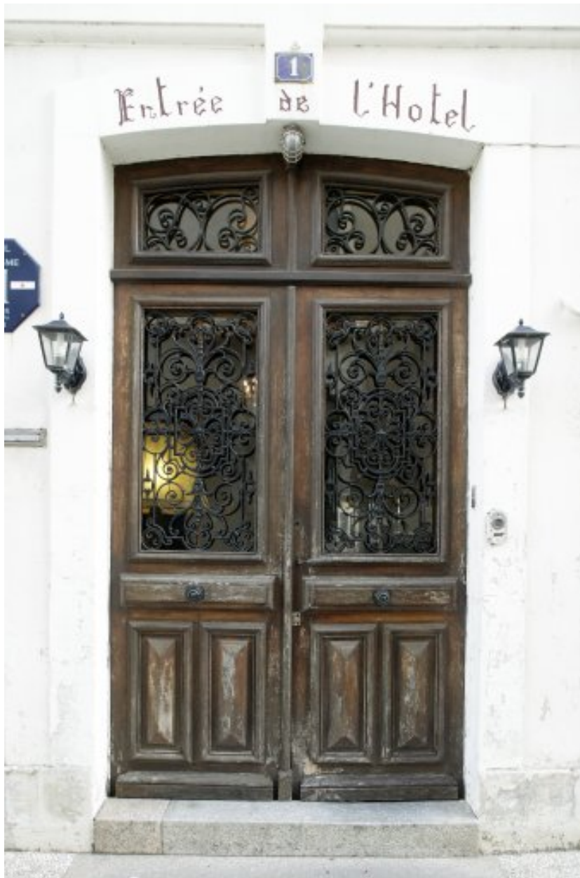
Porte d'entrée de l'hôtel, rue du Croissant.
