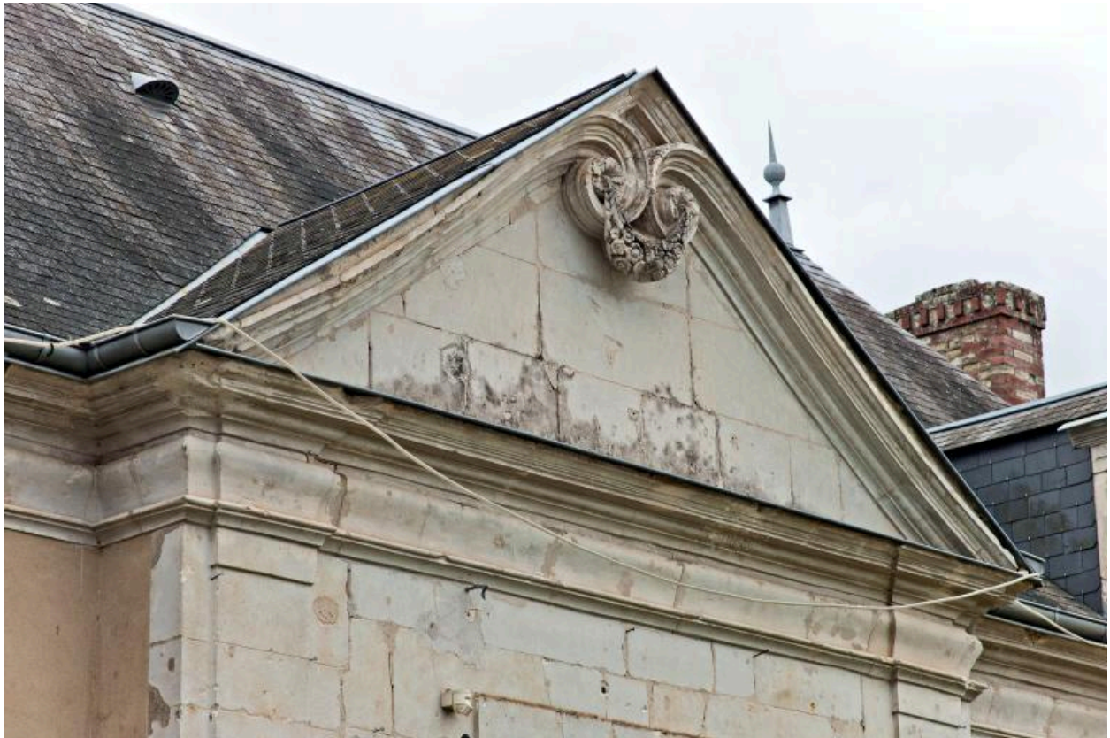
Façade ouest : fronton de l'avant-corps central.
