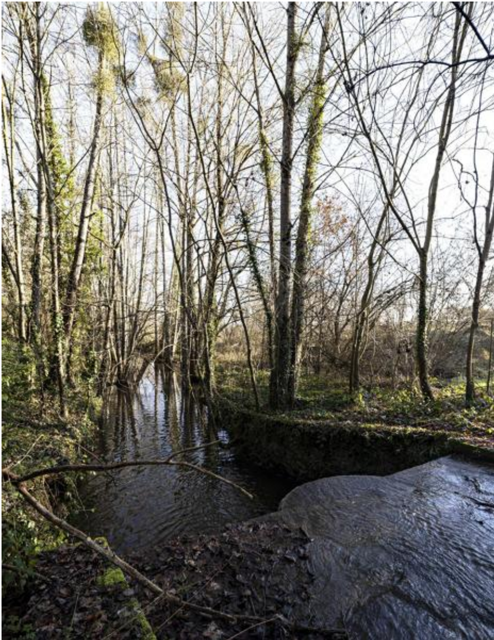
Digue sur le cours d'eau.
