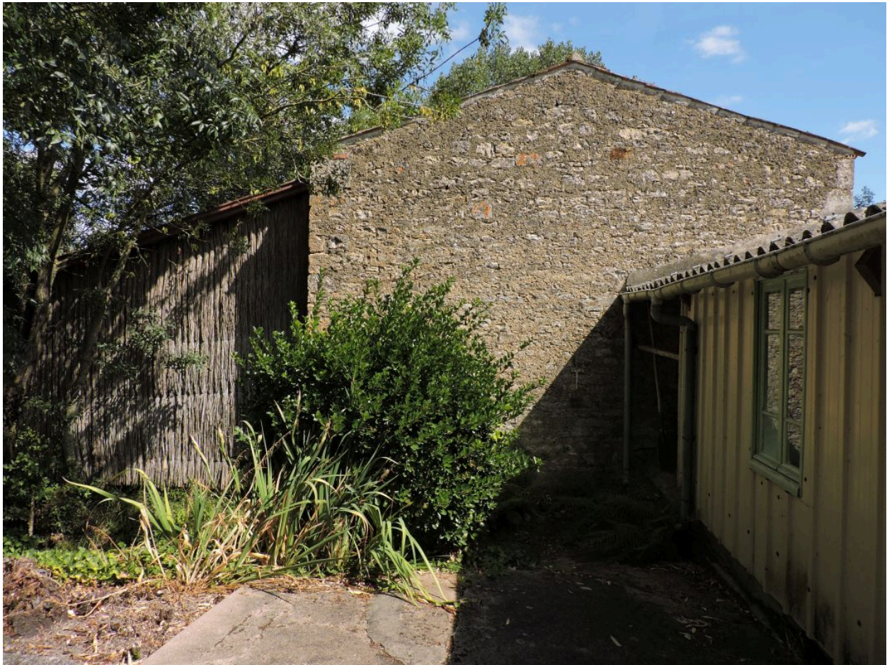
Murs pignons ouest du hangar en pierre et du hangar en roseau, vus depuis le nord-ouest.
