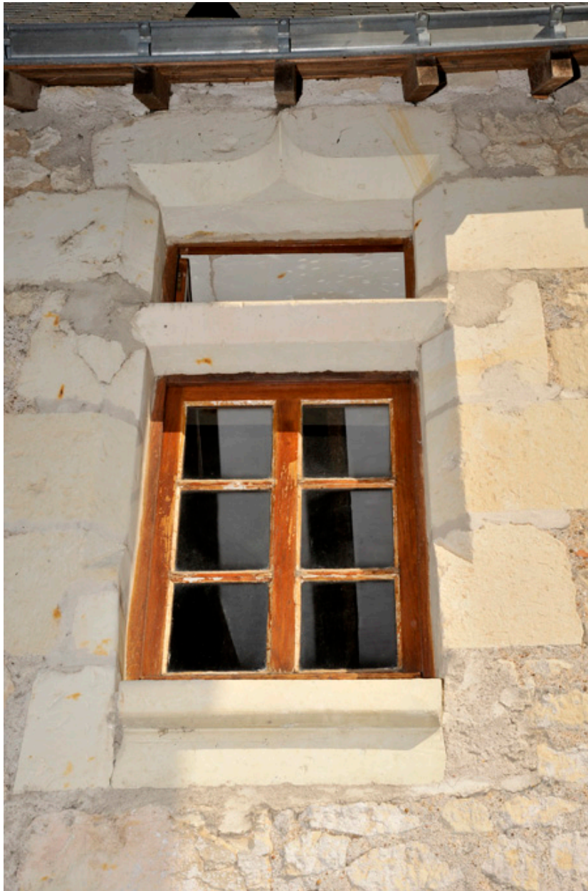
Façade ouest : détail de la demi-croisée, chanfreinée, avec accolade et congés (2).
