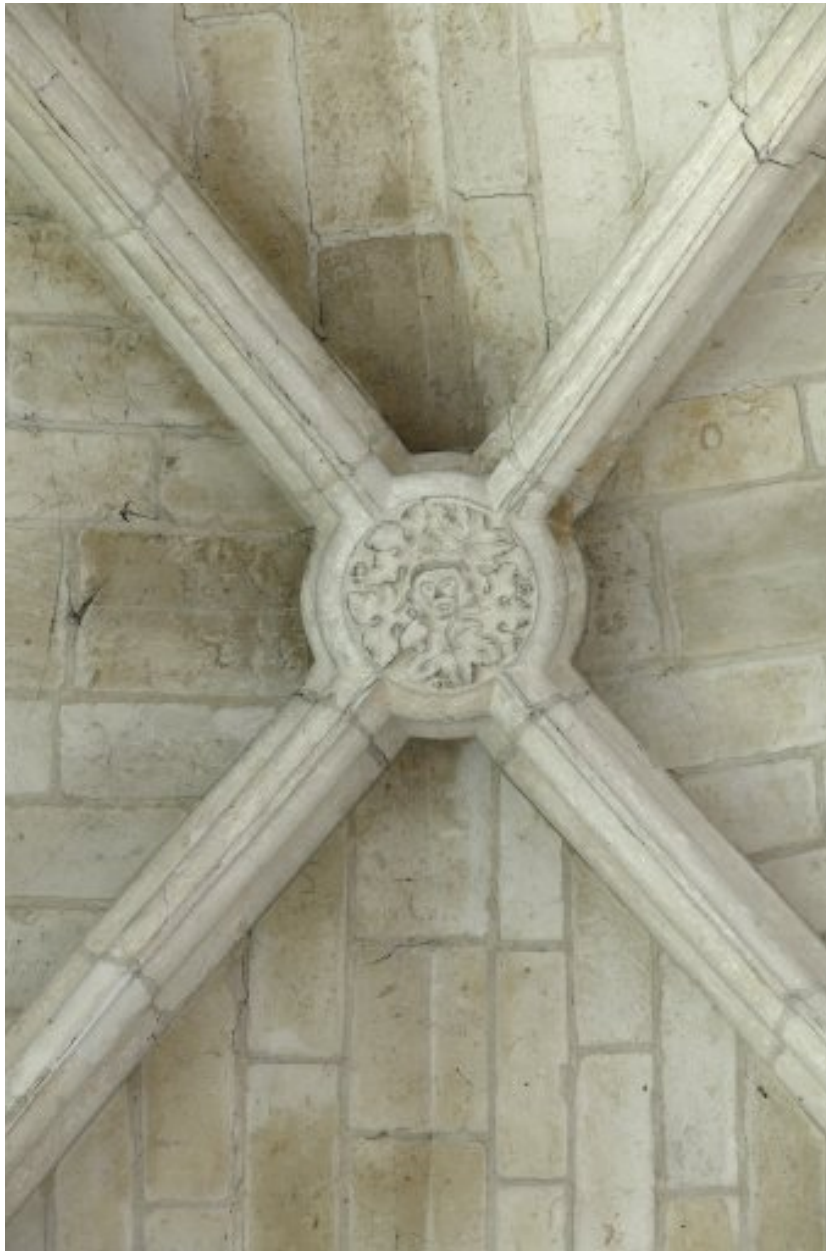
Bas-côté sud de la nef : clef de voûte de la deuxième travée.
