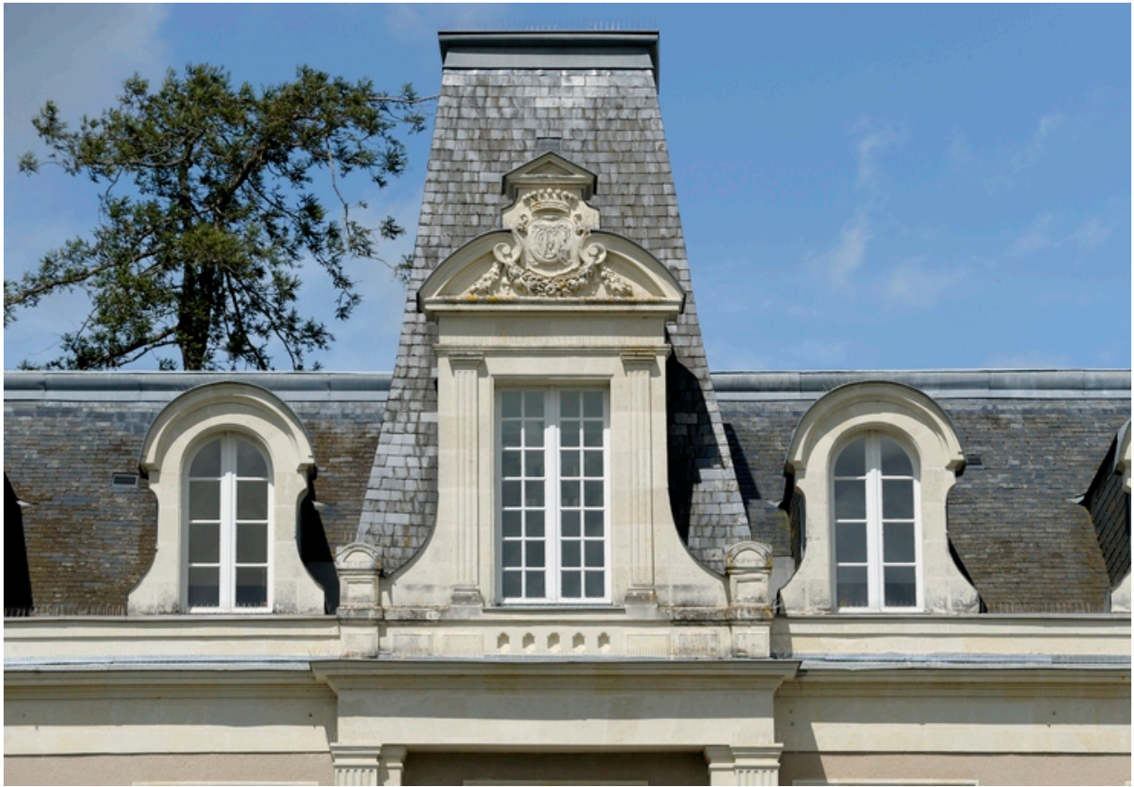
Détail des lucarnes de la façade sud.
