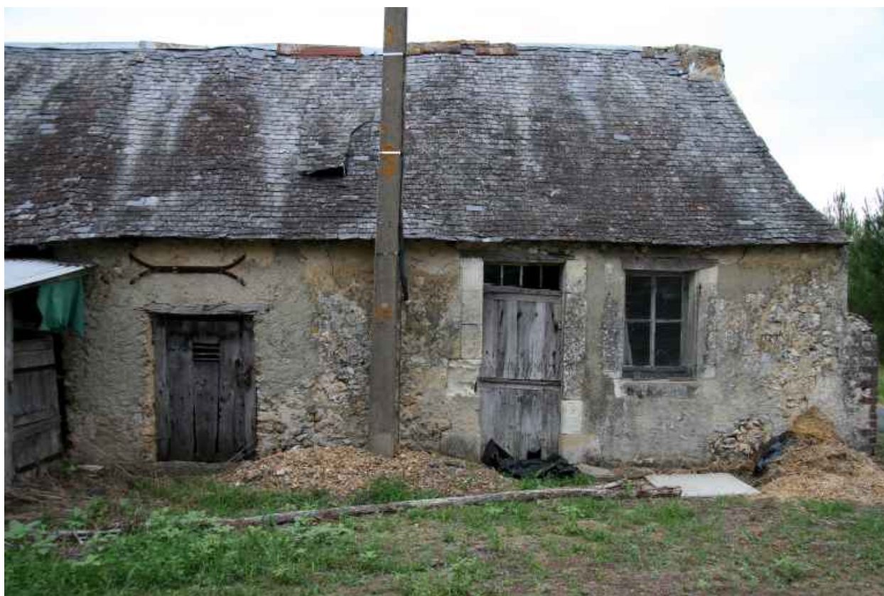
Façade antérieure sur la cour.
