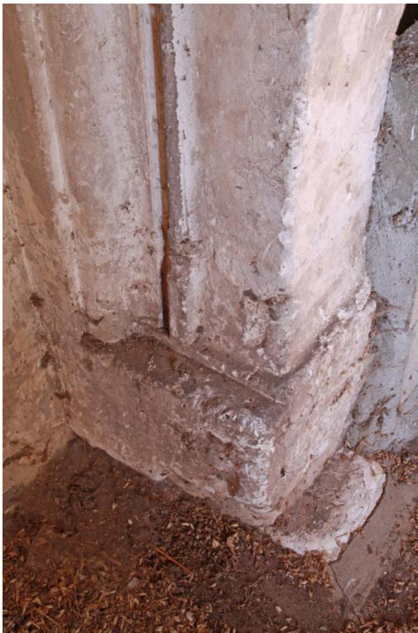
Pavillon, étage, cheminée : détail piédroit gauche.
