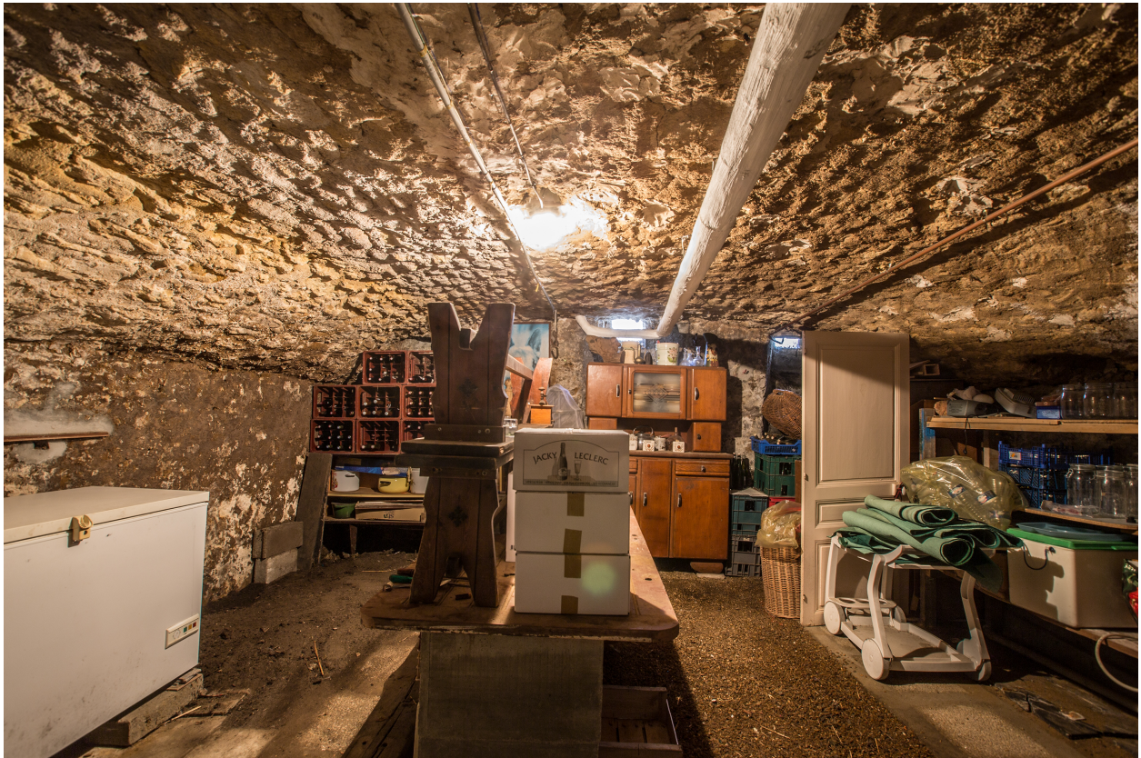
Une cave d'une ancienne maison de tisserand, rue Ledru-Rollin.
