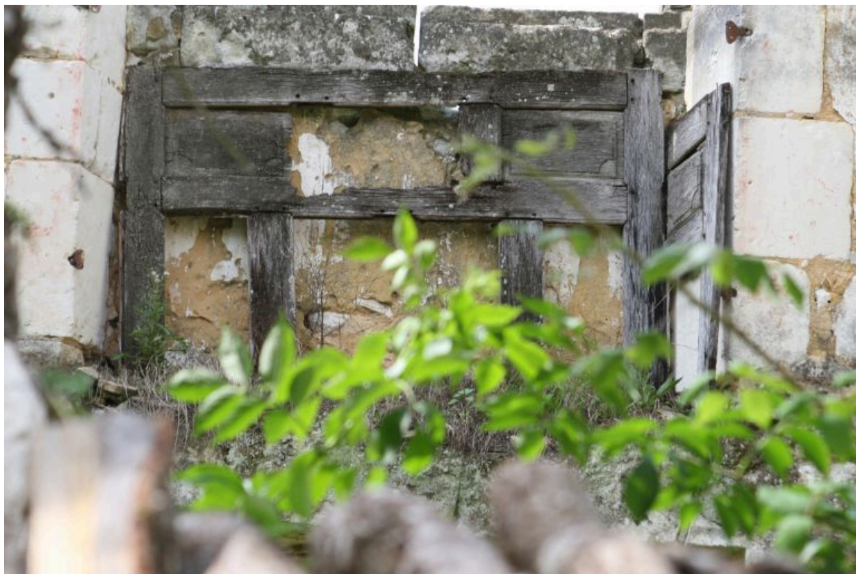
Le logis, 1er étage, chambre centrale : Imabris bas à panneaux et volets tombés.
